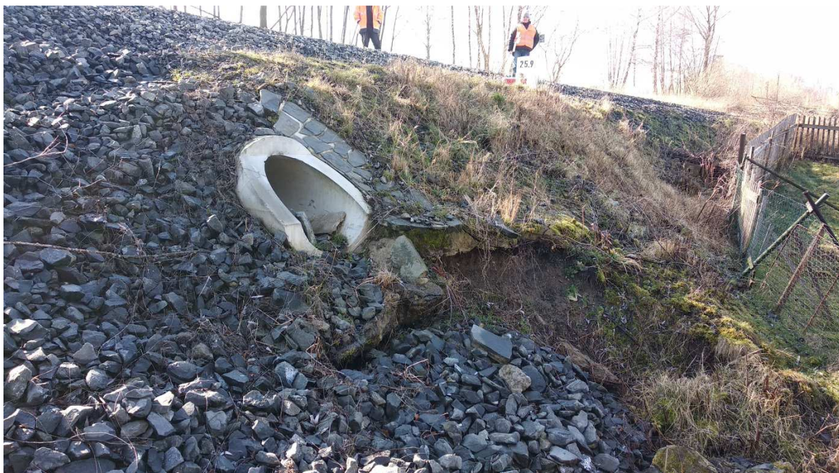
Obr. 2: Propustek ve staničení 25,908 a odlučná stěna sesuvu
