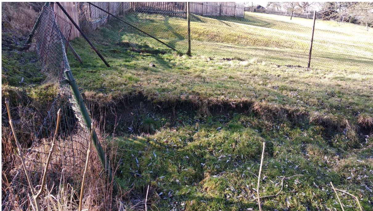
Obr. 1: Pohled na odlučnou stěnu sesuvu u propustku ve staničení 25,908
